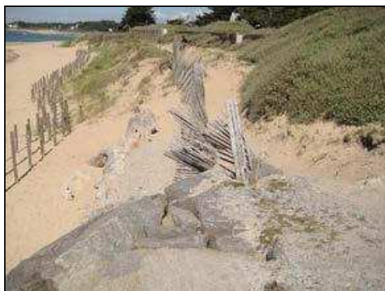
Destruction de l'escalier d'accès à la plage et de l'assiette du sentier littoral en haut de dune.
