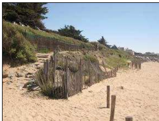
Démantèlement des emmarchements sur une dénivelée du sentier littoral et déchaussement des clôtures de ganivelles.
